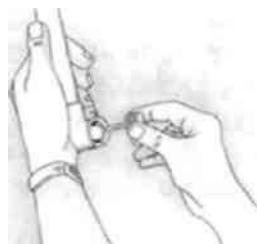
Сборка ПВХ трубы: 1. Нанесите растворитель на внутреннюю поверхность фитинга и на внешнюю сторону трубы.
